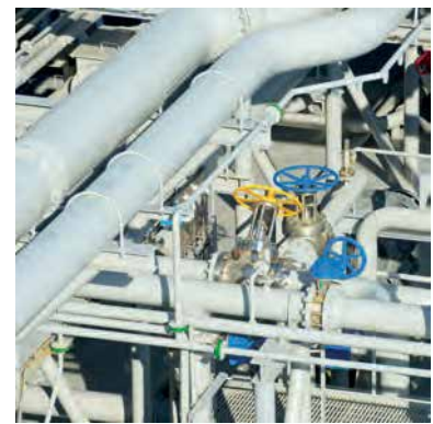
Gas Supply Network & LNG Plant, Al Sowwah Island, Abu Dhabi
